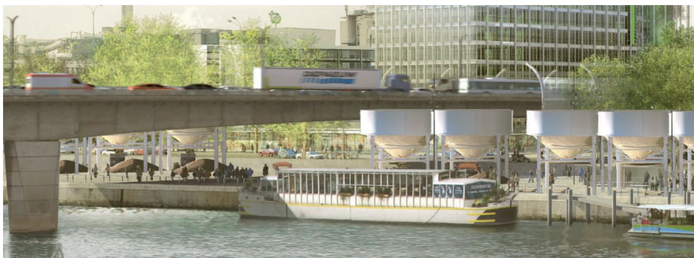
La Seine et le quai d'Ivry, viaduc du boulevard périphérique, un espace conciliant activités économiques et accès localisé du public à la Seine
