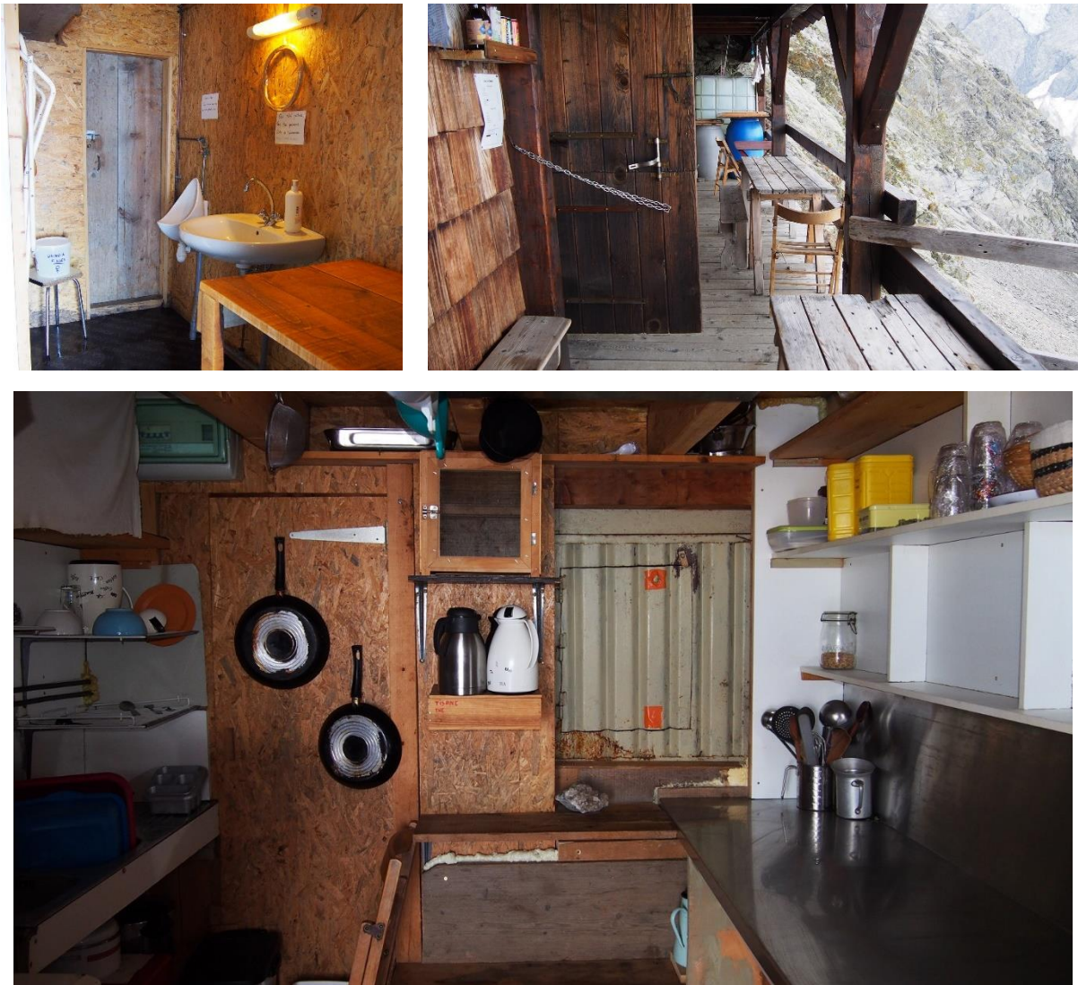
Figure 65 : Photos des conditions dans le refuge prise en 2018 par le gardien
