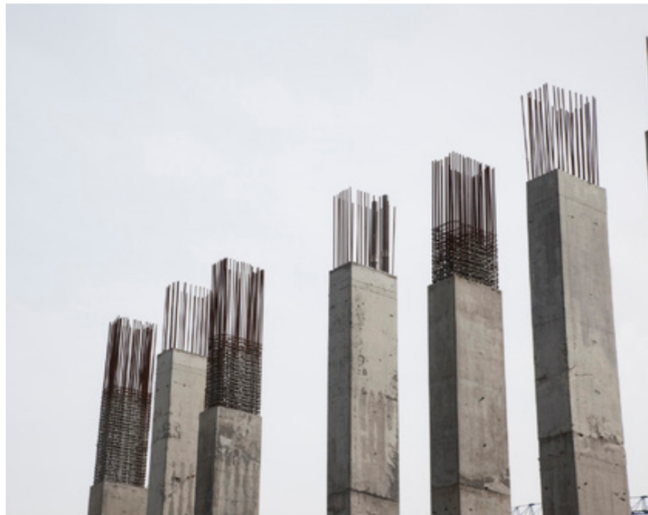
Béton pour la structure
