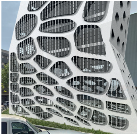
Variation de la structure du bâtiment inspirée du tingidae
