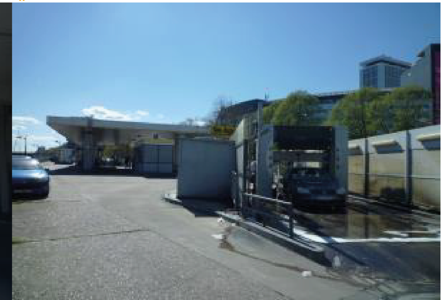
PHOTOGRAPHIE 04 STATION KENNEDY
