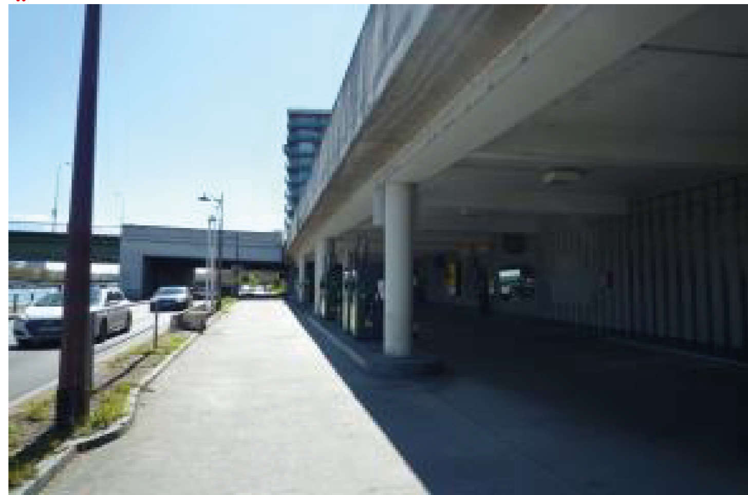
PHOTOGRAPHIE 03 STATION POMPIDOU
