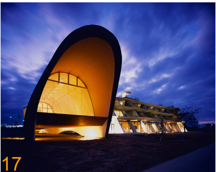
Ambiance extérieur du bâtiment
