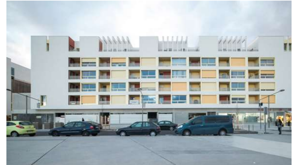
75 logements et commerces sur la place Frederico Garcia Lorca
