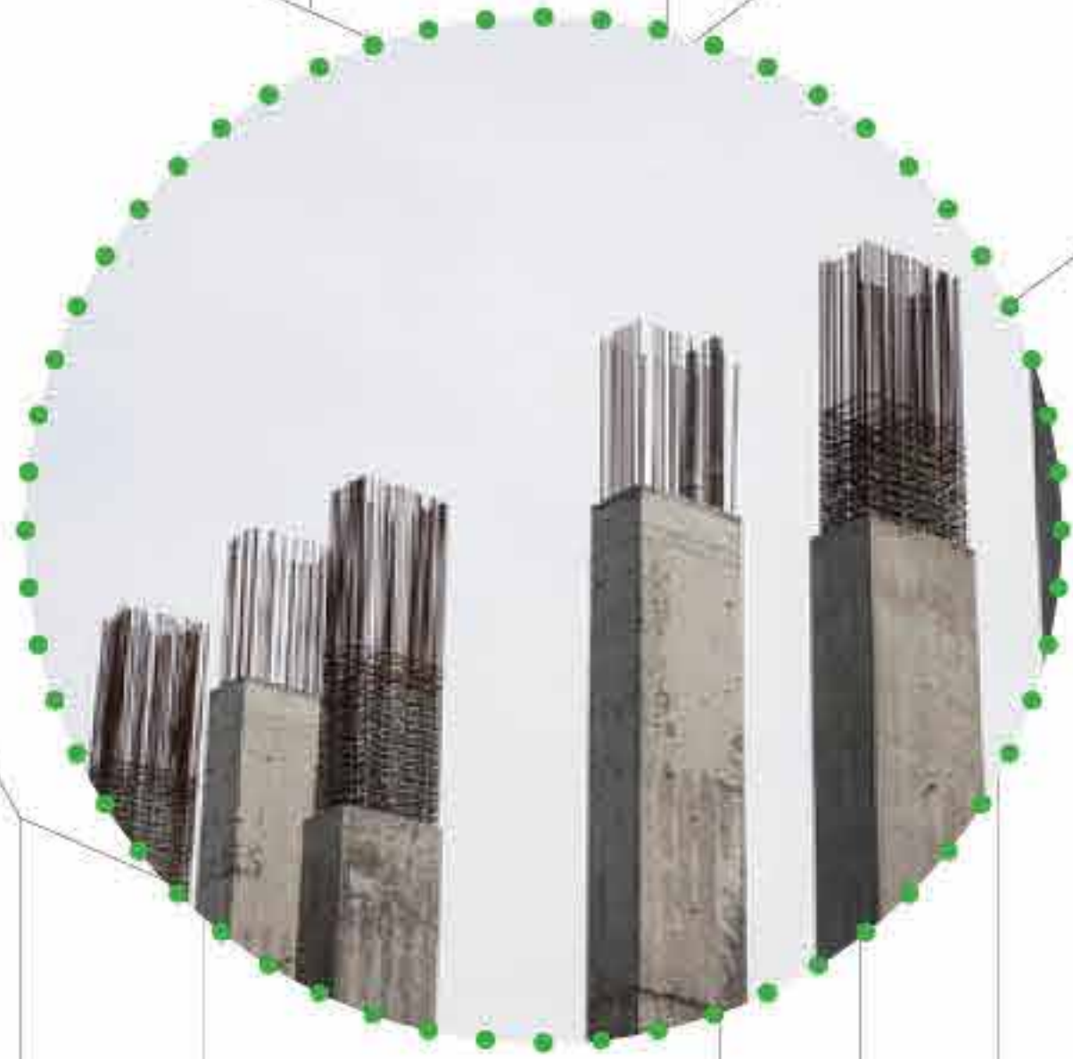
Béton pour les fondations
