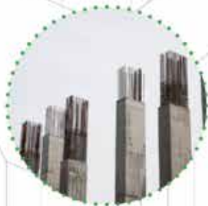
Béton pour les fondations
