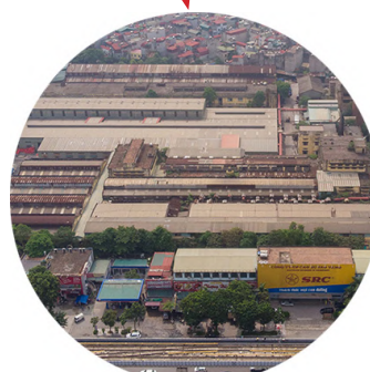
Usine industrielle Sao Vang
