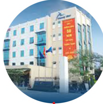
Usine industrielle Thuong Dinh
